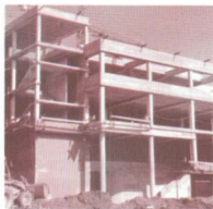
Estructura en construcció d'un edifici del Campus Nord
