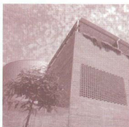
Dues vistes exteriors del mòdul B-1
