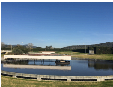
Figura II.1. Decantación secundaria
