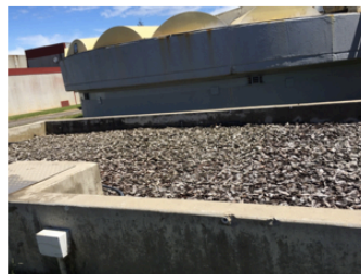
Figura II.7. Desodorizante del gas de línea de fangos
