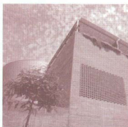
Dues vistes exteriors del mòdul B-1
