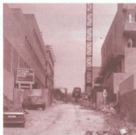
Obres de construcció del Campus Nord
